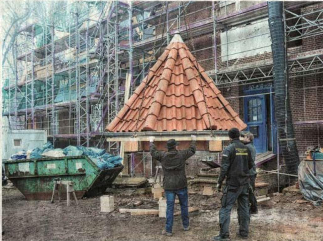
Das knapp zwei Tonnen schwere Bauwerk wurde mit einem Kran aufs Dach gehoben.
